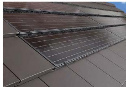
In die Dachhaut integrierte Photovoltaikanlage.
