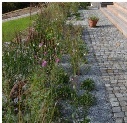
Versickerungsmöglichkeiten im Garten über Pflaster und wassergebundene Beläge
