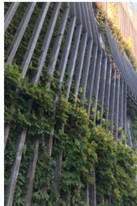
Doppelte Fassade aus Holz, an der Wilder Wein wächst. In die Fassade integrierte Pflanzkübel bieten ausreichend Wurzelraum.
