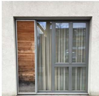
Sicht- und Sonnenschutz durch verschiebbare Holzelemente.
