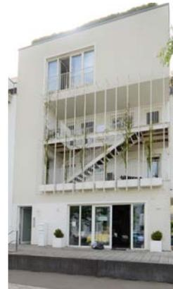
Laubengang bzw. Stahlgitterfassade fungieren wie selbstverständlich als Rankhilfe für die Fassadenbegrünung.
